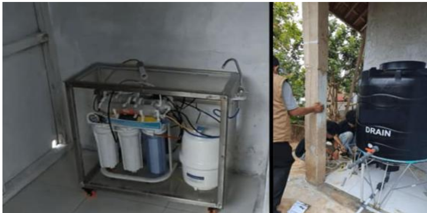
Gambar 4. Hasil akhir dari instalasi produk kegiatan PKM: sistem filterisasi air multi-tahap
